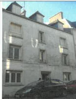
Caractéristiques et état général : immeuble de la reconstruction, maçonnerie moellons, couverture ardoises, structure mixte béton/bois, encadrements de baies saillants. Le bien est **inhabitable en l'état et condamné** : travaux d'aménagement inachevés avec extensions cour (locaux RDC et terrasse R+2), très mauvaises conditions d'éclairage, de ventilation et d'évacuation des eaux pluviales.
