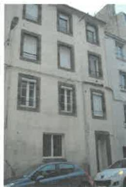
**Caractéristiques et état général :** immeuble néoclassique, maçonnerie moellons, couverture zinc, structure bois, encadrements de baies granit. Le bien est en **mauvais état, partiellement inhabitable** : logements et sanitaires aménagés sans isolation ni protection des planchers et structures bois (fuites et dégâts des eaux récurrents), isolation, chauffage et ventilation insuffisantes.
