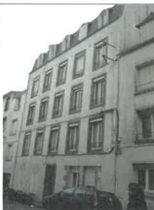
**Caractéristiques et état général :** immeuble néoclassique, maçonnerie moellons, couverture en ardoises, terrasson zinc, structure bois, encadrements de baies granit. Le bien est dans un **état médiocre** : conditions sanitaires et de chauffage insuffisantes en l'absence d'isolation et de ventilation.
