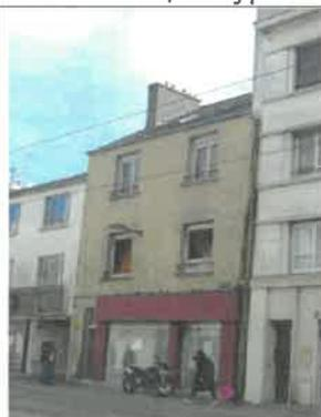
Caractéristiques et état général : immeuble transformé à la reconstruction, maçonnerie moellons, couverture ardoises, structure bois, encadrements de baies avec appuis. L'état général est très mauvais. L'ensemble est **totalemt inhabitable** : commerce RDC désaffecté, infestation de mэрule généralisée sur l'ensemble des planchers, cage d'escalier et charpente, 1er étage incendié, travaux d'aménagement duplex 2ème+combles inachevés.
