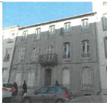
Caractéristiques et état général : immeuble néoclassique, maçonnerie moellons, couverture zinc, structure bois, encadrements de baies granit. Le bien est en **mauvais état, partiellement inhabitable** : logements et sanitaires aménagés sans isolation ni protection des planchers et structures bois (fuites et dégâts des eaux récurrents), isolation, chauffage et ventilation insuffisantes.
